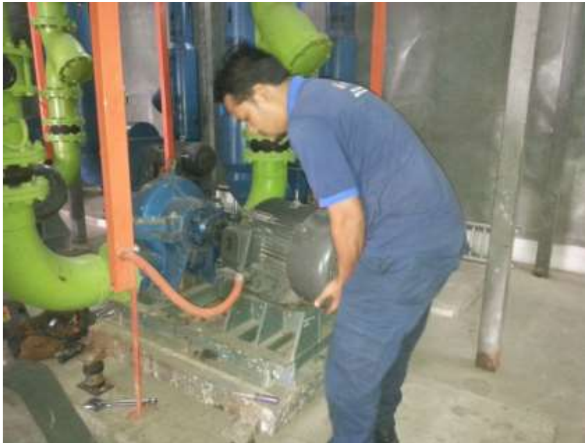
PENYELENGGARAAN CHILLED WATER PUMP
