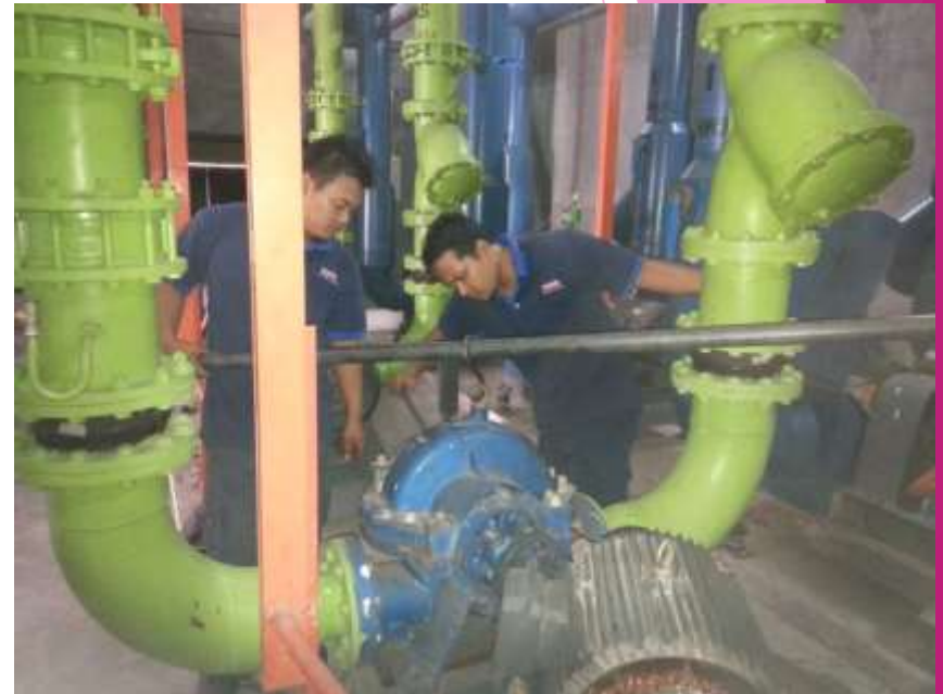
PENYELENGGARAAN CHILLED WATER PUMP
